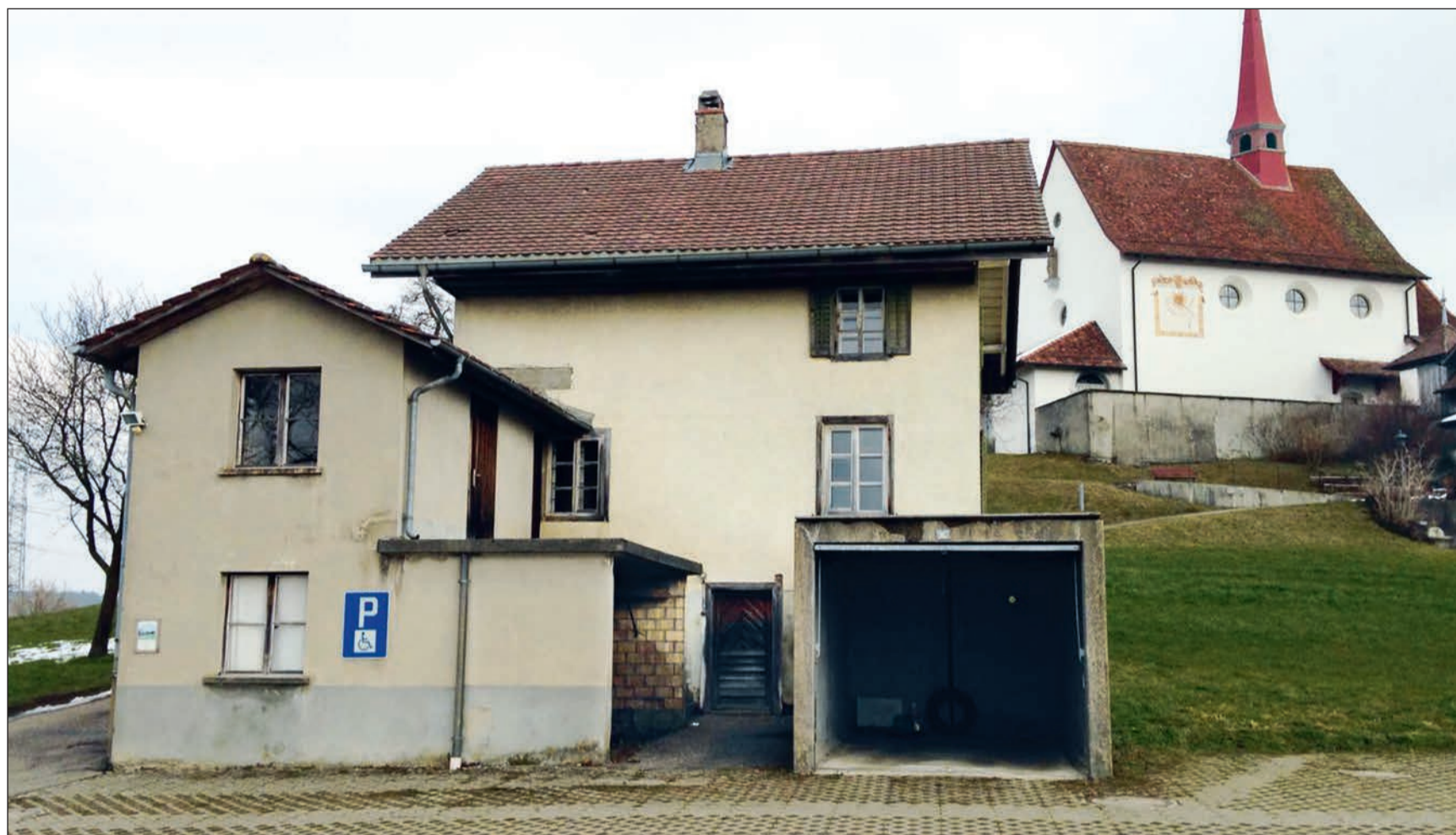
Das Sigristenhaus unterhalb der Kaplanei.
