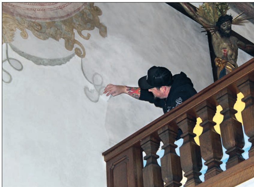
Peeling für die Innenwand: Stukkateur Adrian Zopf reinigt mit einem Schwamm die Flächen – mit sichtbarem Resultat.
