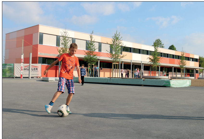
Das Schulhaus in Rickenbach aus den Sechziger Jahren wurde mit einem zeitgemässen Bau für die Kindergärten ergänzt. (Bild: jap)
