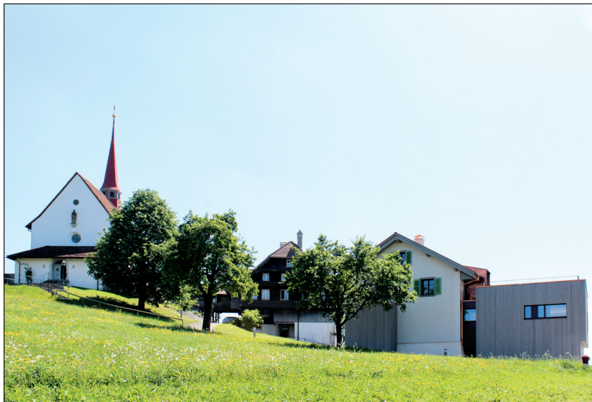
Das historische Ensemble Kapelle, Kaplanenhaus und Sigristenhaus auf dem Gormund bekam eine moderne Erweiterung. (Bild: uke)
